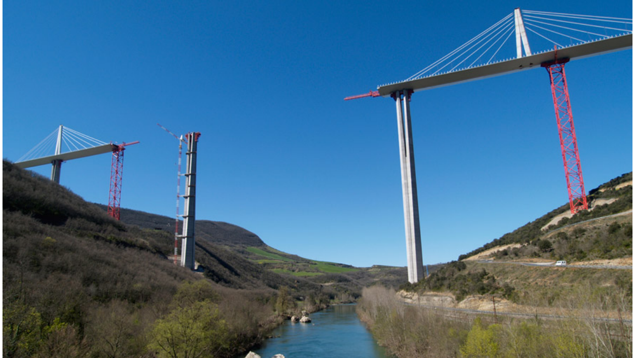
(A) Construction of the viaduct (Courtesy of Le Viaduc de Millau)
