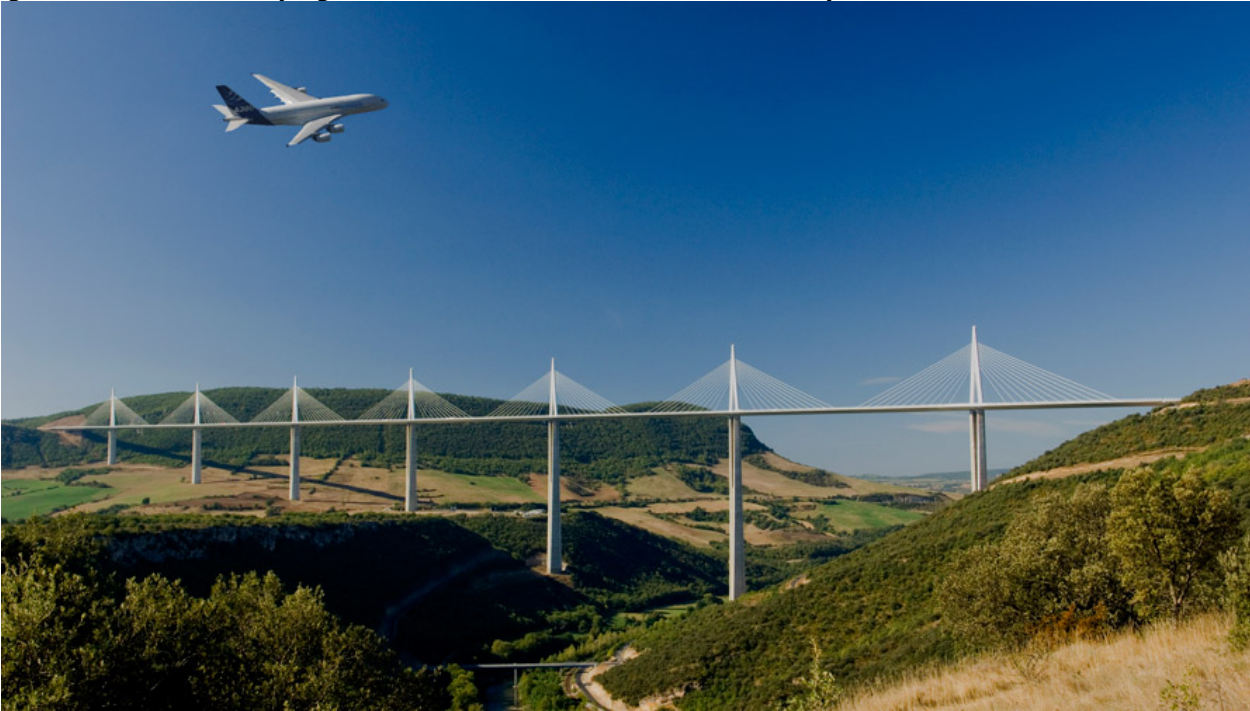
Fig. 1-4 - Airbus A380 flying over Le Pont de Millau (France) (Courtesy of Le Viaduc de Millau)
