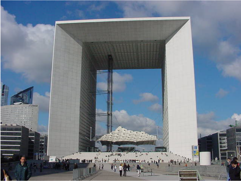
Fig. 1-2 - La Grande Arche, La Défense (France) (Courtesy of VF Communication, La Grande Arche) - Looking West
