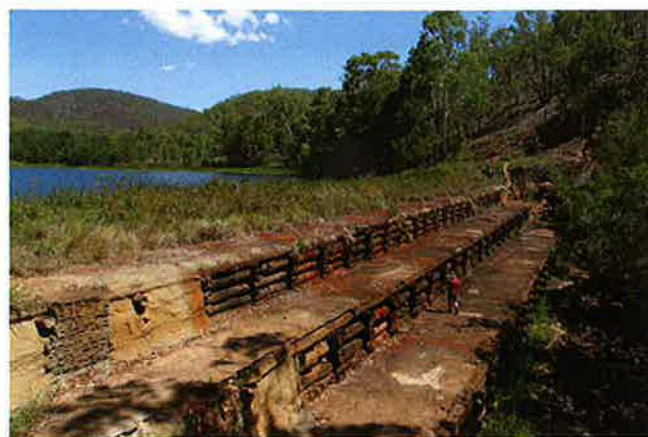
Barrage en remblai et déversoir en caissons en bois de Loudon Mill à Irvinebank, nord Queensland (Australie). Construit en 1943, il est toujours en utilisation Source : Gordon GRIMWADE
