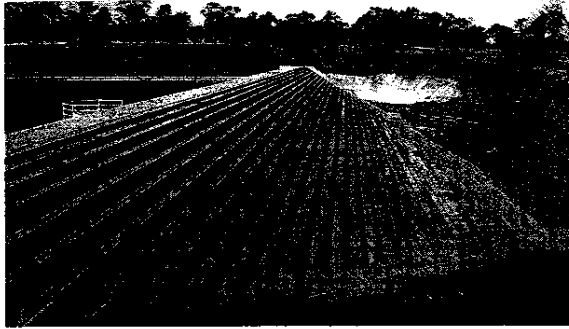
Figure 2 : Barrage de Melton, Victoria, Australie en Janvier 2000 Barrage en remblai (1916, rehaussé en 1941 et en 1967) ( H = 35 m) - Evacuateur de crue secondaire par déversement sur le parement aval, protection avec du béton conventionnel, capacité : 2,800 \text{ m}^3/\text{s} (coursier secondaire), W = 181 m (en crête), h = 0,6 m, \alpha = 26,5^\circ .
