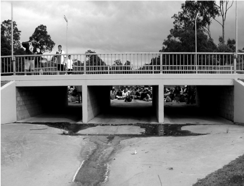
Figure 1 : Buse de drainage conventionnelle (entrée),
