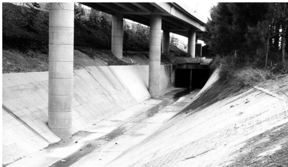
**Figure 6 : Entrée du système de drainage à Pertes de Charge Minimales (PCM) de Marshall Road (Brisbane, Australie) — Conception originale en 1975 :  $Q_{des} = 170 \text{ m}^3/\text{s}$ , afflux nul — Vue vers l'aval en août 2000 — Le lecteur notera la présence de deux piles supportant la nouvelle voie de bus, construite entre 1999 et 2000.**
