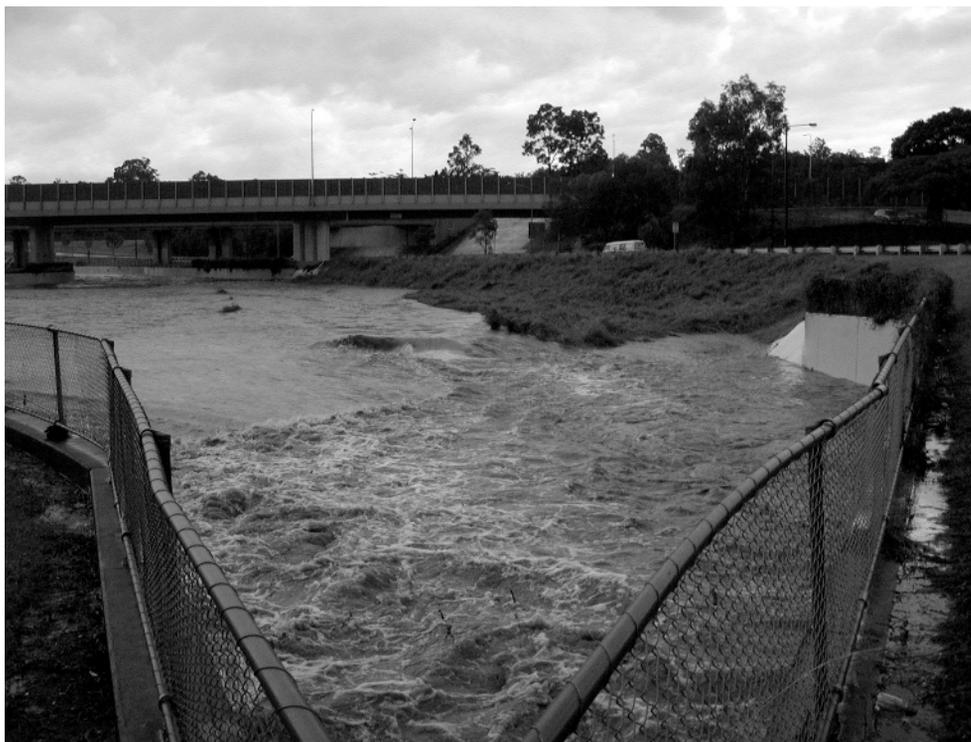
**Figure 5 : Fonctionnement du système de drainage à Pertes de Charge Minimales (PCM) de Ridge Street (Brisbane, Australie), le 31 déc. 2001, en fin d'orage ( $Q \sim 60$  à  $80 \text{ m}^3/\text{s}$ ) —  $Q_{\text{des}} = 220 \text{ m}^3/\text{s}$ ,  $B_{\text{max}} = 42 \text{ m}$ ,  $B_{\text{min}} = 21,3 \text{ m}$ ,  $L_{\text{barrel}} = 54 \text{ m}$ ,  $\Delta z_0 = 0,6 \text{ m}$ ,  $D = 3,0 \text{ m}$  — Convergent du système PCM — Vue vers l'amont —**
